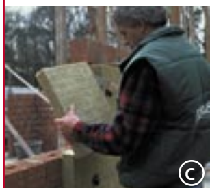
Verwerking SpouwPlaat 433 a. in halfsteensverband plaatsen b. specieresten verwijderen c. afsnijden aan ramen en deuren
